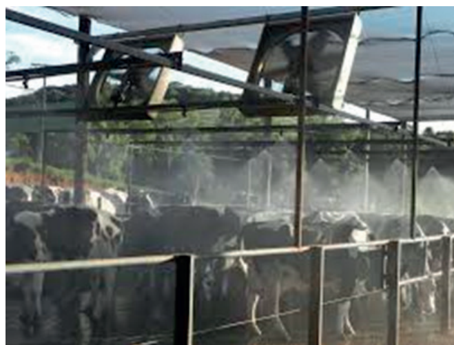
Figura 3 – Ventiladores e aspersores
